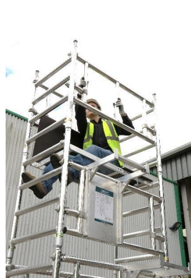
28. Monte 2 marcos de barandilla con el gancho superior (mirando hacia fuera) colocado por encima del peldaño más alto del marco.
