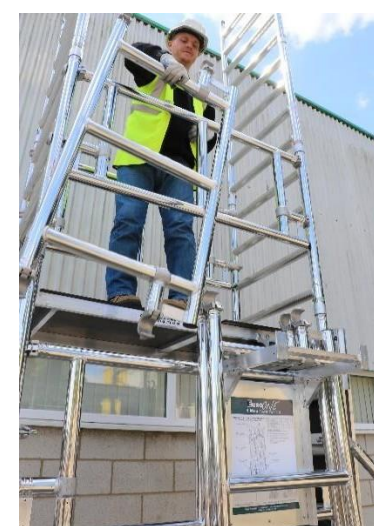
19. Descuelgue uno de los marcos de barandilla lateral que dejó colgados en el soporte de montaje frontal y súbalo como se muestra en la foto.
