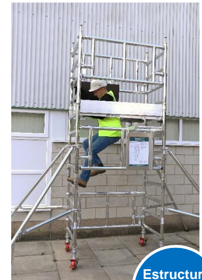
15. Acceda a la plataforma utilizando la trampa, como se muestra en la foto, y empiece a trabajar.
