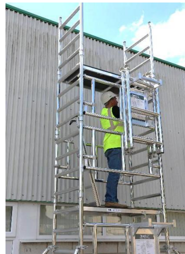
27. Coloque la plataforma 1 peldaño por encima de la ubicación del marco lateral, como se muestra en la foto.
