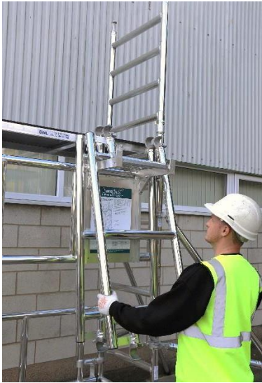
11. Cuelgue los marcos de rodapié en el soporte de montaje frontal.
