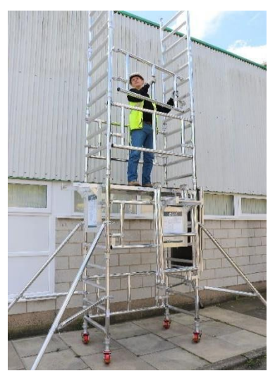
20. Monte la barandilla lateral por encima del tercer peldaño, por encima de la existente, como se muestra en la foto.
