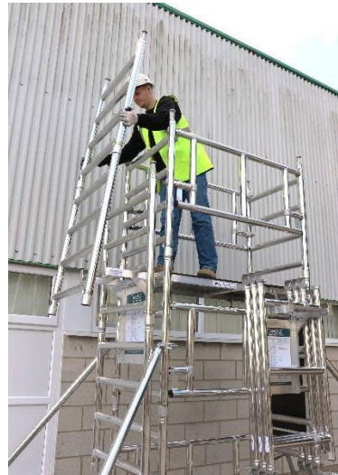
17. Descuelgue un juego de marcos del soporte de montaje lateral y móntelos.
