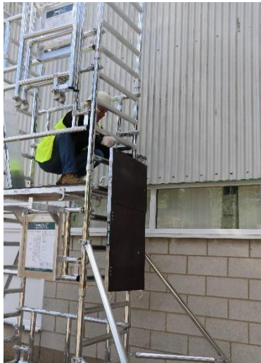
26. Recupere el resto de la plataforma de la sección inferior y súbala por el marco lateral.
