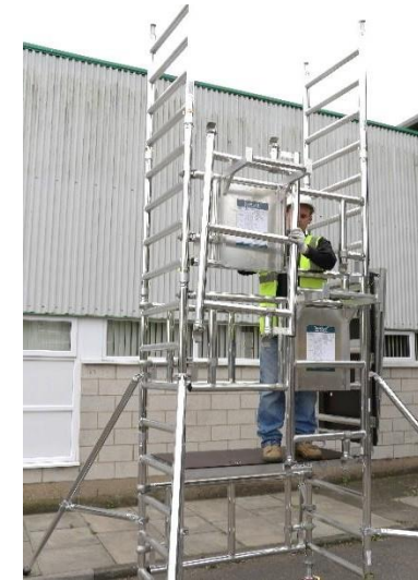
25. Descuelgue uno de los marcos de barandilla lateral que dejó colgados en el soporte de montaje frontal y colóquelo como se muestra en la foto.
