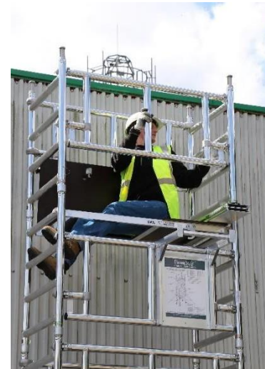
29. Monte 2 marcos de barandilla con el gancho superior (mirando hacia fuera) colocado por encima del peldaño más alto del marco.
