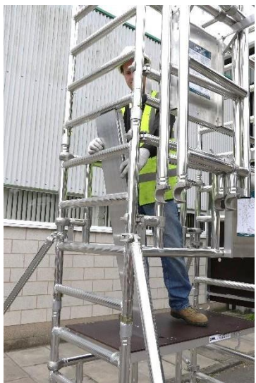
26. Coloque temporalmente la pieza del rodapié en la plataforma para poder acceder a la plataforma adicional almacenada.
