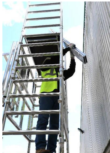
28. Suba la pieza del rodapié de la plataforma inferior a la superior asegurándose de que la coloca sobre la sección plana de la plataforma, como se muestra en la foto.
