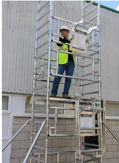
22. Coloque el soporte de montaje en el peldaño superior del marco de barandilla más alto, como se muestra en la foto..
