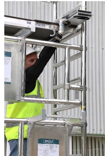
29. Suba la pieza del rodapié de la plataforma inferior a la superior asegurándose de que la coloca sobre la sección plana de la plataforma, como se muestra en la foto.
