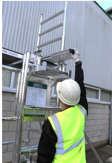
12. Suba la pieza del rodapié de la plataforma inferior a la superior asegurándose de que la coloca sobre la sección plana de la plataforma, como se muestra en la foto.
