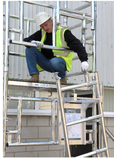
23. Recupere los 2 marcos de barandilla colgados en el soporte de montaje inferior (frontal) y súbalos al soporte de montaje que acaba de colocar en posición más alta.
