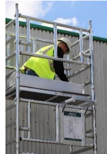
14. Monte el rodapié desplegando la pieza encima de la plataforma (utilice el etiquetado como referencia para asegurarse de que lo instala de forma correcta).
