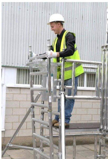
21. Descuelgue un juego de marcos del soporte de montaje lateral y móntelos.
