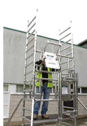
24. Recupere el soporte de montaje lateral «vacío» y colóquelo en la parte frontal de la torre (en el peldaño superior del marco de rodapié más alto, como se muestra en la foto).
