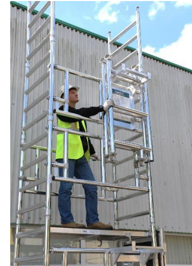
24. Los marcos se recolocan como se muestra en la foto.
