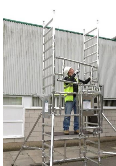
23. Descuelgue uno de los marcos de barandilla lateral que dejó colgados en el soporte de montaje frontal y colóquelo como se muestra en la foto.
