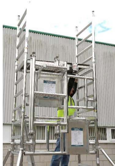
27. Coloque la plataforma 1 peldaño por encima de la ubicación del marco lateral, como se muestra en la foto.
