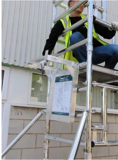
21. Descuelgue el soporte de montaje «vacío» del lateral de la torre.
