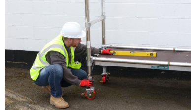
5. Coloque la plataforma sin trampilla en el peldaño. (Ver montaje base para la altura de la plataforma deseada). Nivele la torre mediante las patas regulables usando un nivel de burbuja como guía.
