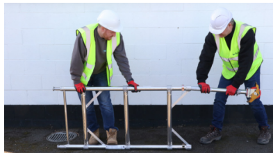
2. Inserte 2 patas ajustables con rueda giratoria en el marco base.
