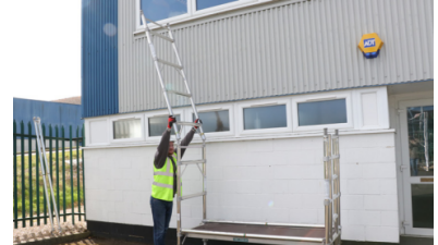
6. Agregue más bastidores asegurándose de que la escalera siempre quede de manera continua.
