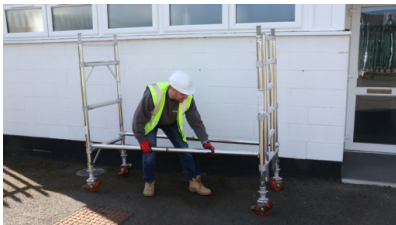
4. Coloque 2 barras horizontales en el vértice del bastidor por encima del primer peldaño. Las barras horizontales se encajan desde el interior de la torre mirando hacia afuera.
